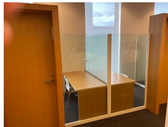
各個室には天井が付いておらず、遮音性のない構造になっています。
